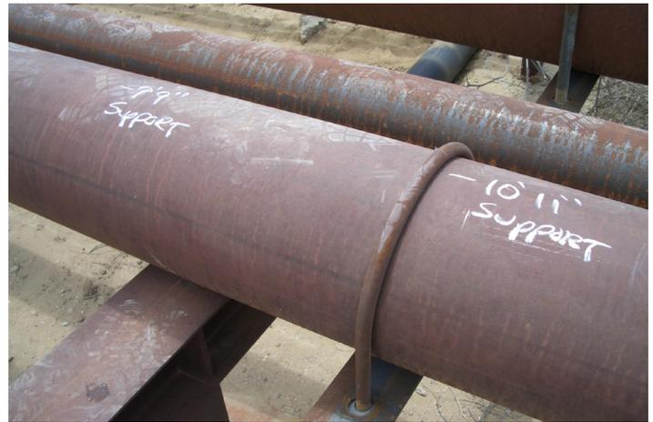
La técnica de Ondas Guiadas permite la inspección bajo soportes simples o tipo abrazadera.
